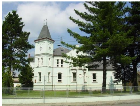
Budova ZŠ v Zábřehu
