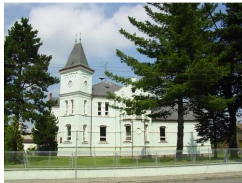
Budova ZŠ v Zábřehu
